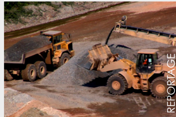
EIFFAGE Travaux Publics Ouest « les chantiers de l'Ouest »
